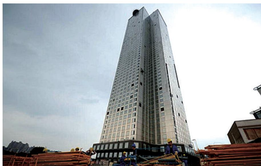
湖南长沙一栋名为“小天城”的57层高楼火了,因为建起它仅仅花了19天。记者了解到,“小天城”的施工建造采用工厂化的模式,即将墙体、立柱、楼板、门窗等零部件事先在工厂中生产好,然后运到工地拼装起来,这是建筑产业化发展到新阶段的结果。由于大楼大部分零件是钢材,90%以上的组件可在拆后返厂,重复利用。
