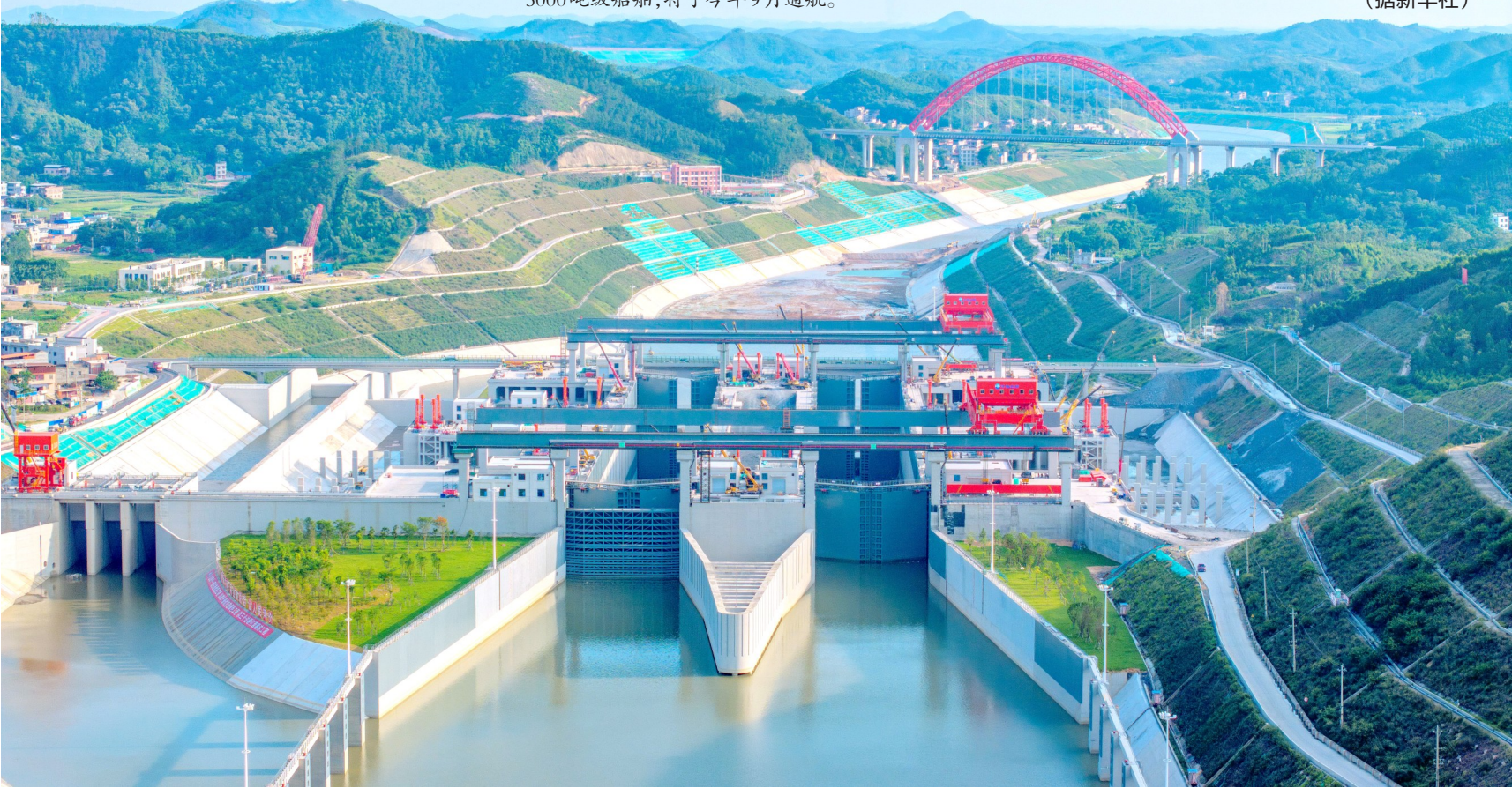
这是6月3日拍摄的广西平陆运河马道枢纽充水现场(无人机照片)。 6月3日,随着平陆运河马道枢纽和企石枢纽正式开始充水,平陆运河全线通水,全面进入有水调试阶段。 平陆运河是西部陆海新通道骨干工程,全长134.2公里,北起广西横州市平塘江口,经灵山县陆屋镇,沿钦江进入北部湾,作为新中国成立以来我国第一条国家层面统筹的通江达海的运河工程,平陆运河可通航5000吨级船舶,将于今年9月通航。 (据新华社)
