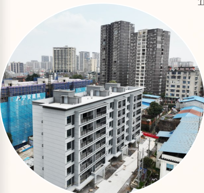
咸安交通路兴达小区危旧房改造项目
