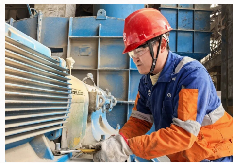
华新水泥(赤壁)有限公司检修现场
