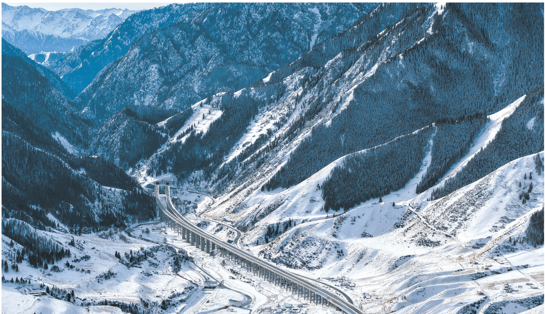
这是新疆乌尉高速公路前峡1号隧道及附近路段(12月20日摄,无人机照片)。
