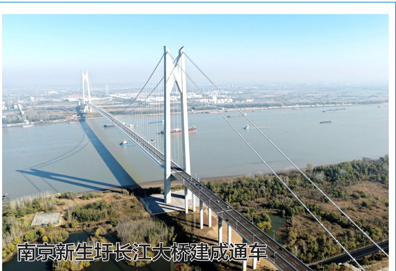
11月26日,南京新生圩长江大桥建成通车。据悉,南京新生圩长江大桥是南京主城连接江北新区的重要枢纽,项目全长约13.17公里,主线设计时速80公里,双向六车道。该桥的通车对提升南京长江干线过江能力、完善区域路网体系具有重要意义。(据新华社)
