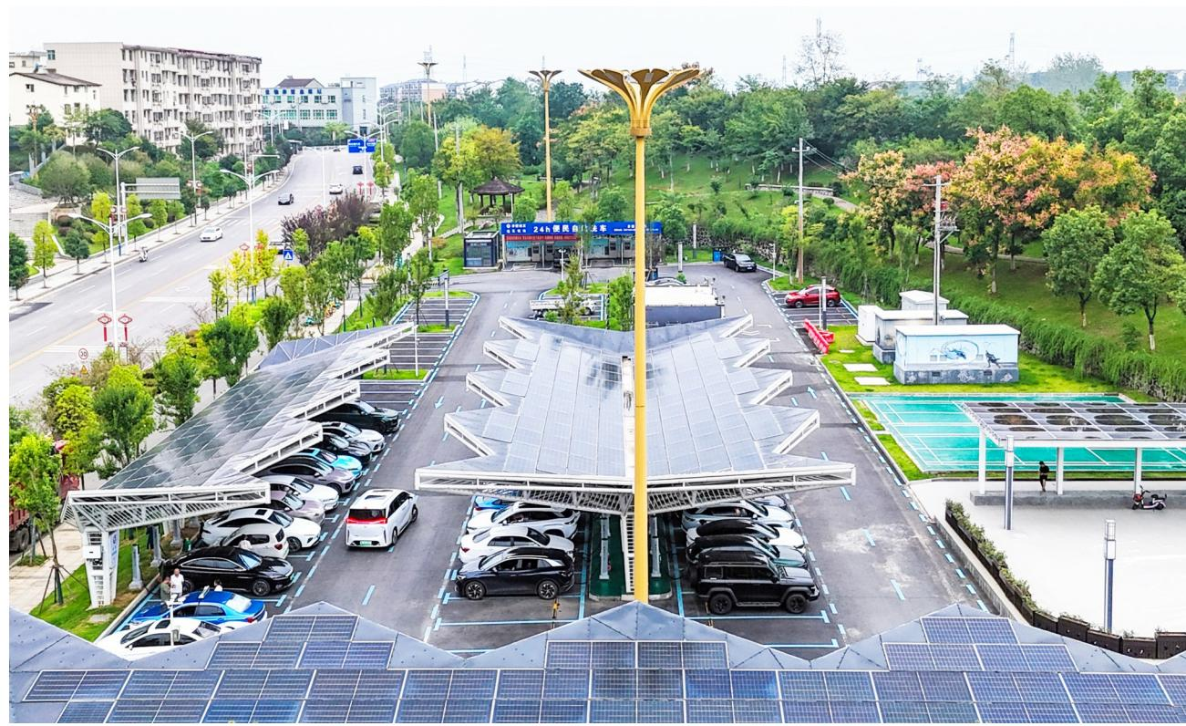
加速推进。赤强驾校光充储项目现场,一排排崭新的光伏板已整齐铺设在停车场和办公楼顶,工人们正抓紧进行光伏车棚钢结构焊接及防腐处理。据了解,该项目总投资约370万元,配备交流桩10台、400千瓦时超充桩2台,预计光伏装机容量600千瓦时、储能容量510千瓦时。项目负责人金庭威介绍,该站点已完成土建基础施工、光伏车棚安装和办公楼屋面光伏安装,下一步将进行屋面
