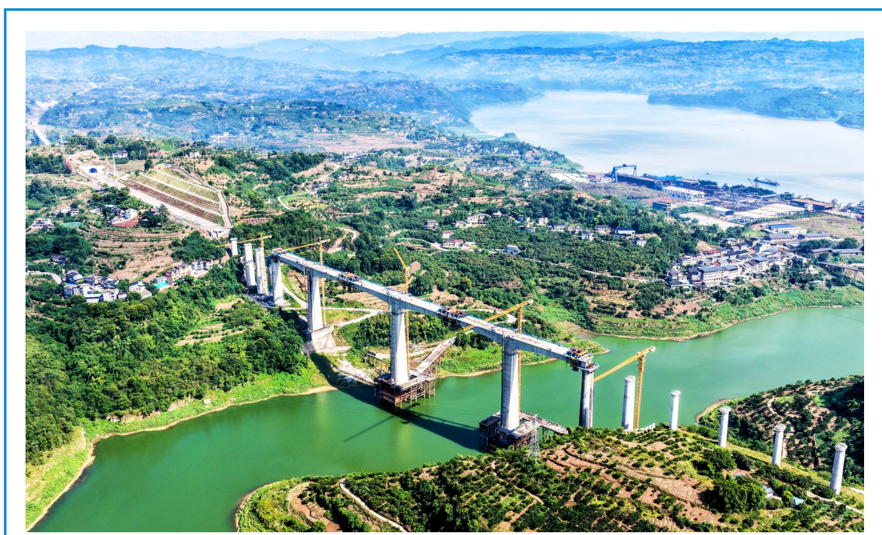
8月18日,由中国铁建大桥局承建的重庆至万州高速铁路(渝万高铁)渠溪河双线特大桥顺利合龙。渝万高铁渠溪河双线特大桥位于重庆市涪陵区溪溪镇,横跨长江支流渠溪河,全长约953米,是全线重难点工程。渝万高铁是我国“八纵八横”高铁网包(银)海、京昆通道的组成部分,正线全长251公里,设计时速350公里。 据新华社
