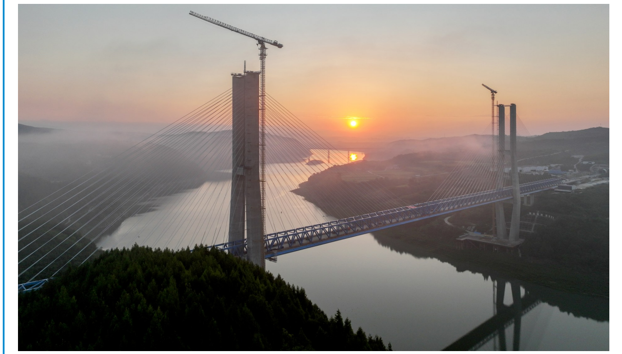
8月18日,由中铁十一局承建的西安至十堰高速铁路(简称“西十高铁”)汉江特大桥钢桁梁顺利合龙。汉江特大桥位于湖北省十堰市,跨越丹江口水库库区,是西十高铁全线控制性工程。西十高铁西起陕西西安,终点为湖北十堰。西十高铁开通后,西安至十堰将实现1小时内到达,汉江特大桥钢桁梁的合龙为全线如期建成通车奠定了基础。 据新华社
