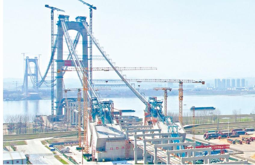
4月15日,双柳长江大桥南岸,长长的猫道跨过长江,串起了大桥南北两岸,大桥的主缆已经架设完工。工人们正在进行紧缆施工,为钢箱梁吊装施工做准备。在双柳长江大桥下游约50公里处,燕矶长江大桥正在紧锣密鼓地架设主缆,平均每天拉索5根左右。
