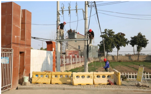
正在拆除变压器
