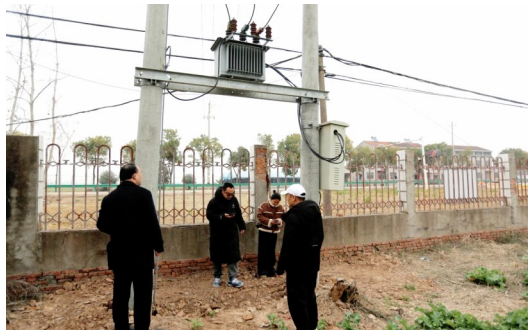
迁移后的变压器远离主通道
