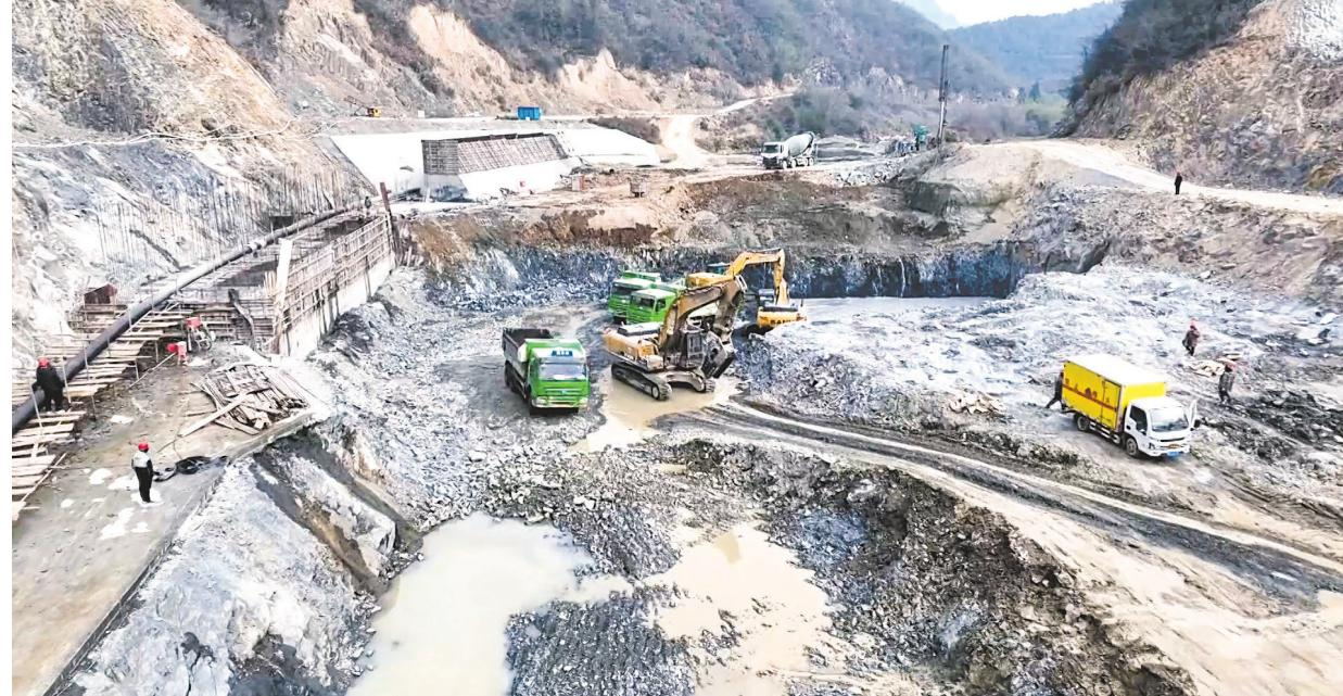
7月完工。该工程由大坝、溢洪道、取水口和输水管线及附属设施等组成。木三李水库最大坝高45米，总库容821万立方米，水库年供水量962.7
