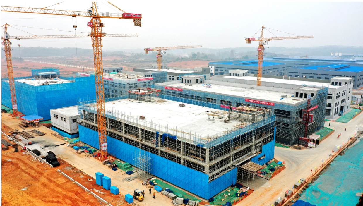
2024年12月27日,咸安经济开发区东湖高新咸安产业园项目,工人正在建设厂房。 记者 夏正锋 摄
