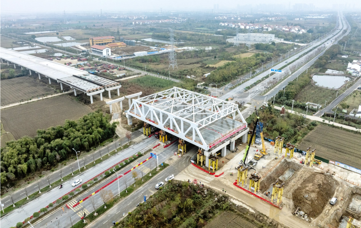
11月19日拍摄的施工现场(无人机照片)。当日,由中铁十一局承建的新港高速双柳长江大桥及接线工程跨津津大道钢桁梁顶推施工完成。钢桁梁长68米,高10.5米,宽36.24米,整体重量约1675吨,跨越津津大道10条车道。(据新华社)
