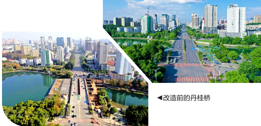
►改造后的丹桂桥
