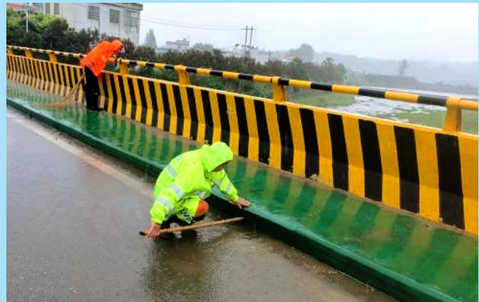
崇阳县公路养护事务管理中心养护技术人员开展桥涵“体检”
