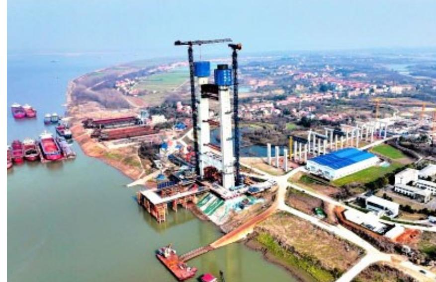
个节段，设上、中、下三道横梁。我们目前已经施工完成了25个节段，正在进行中横梁支架的安装，即将进入中横梁施工。
