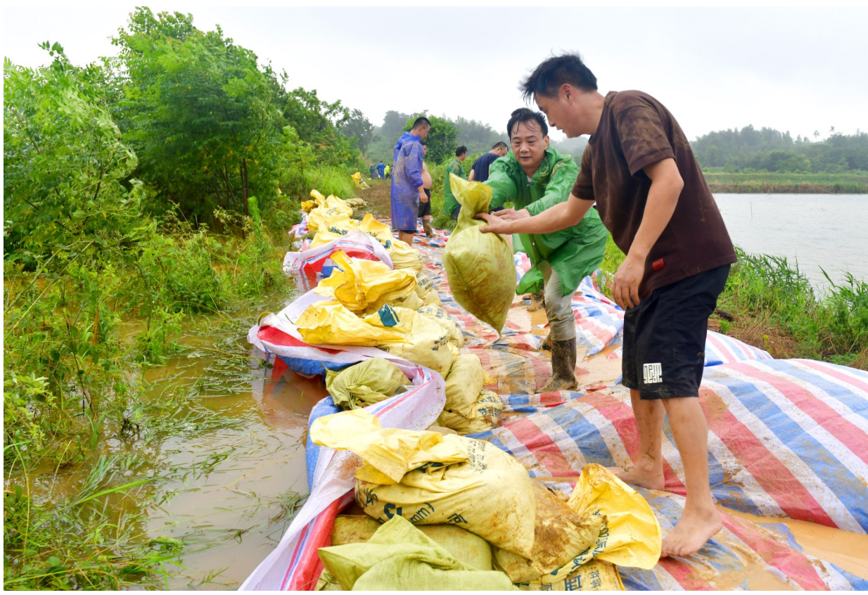
6月30日,咸安区官埠桥镇泉水湖村泉水湖围垸大堤,当地干群正在抢筑子堤。 记者 夏正锋 通讯员 沈希 摄
