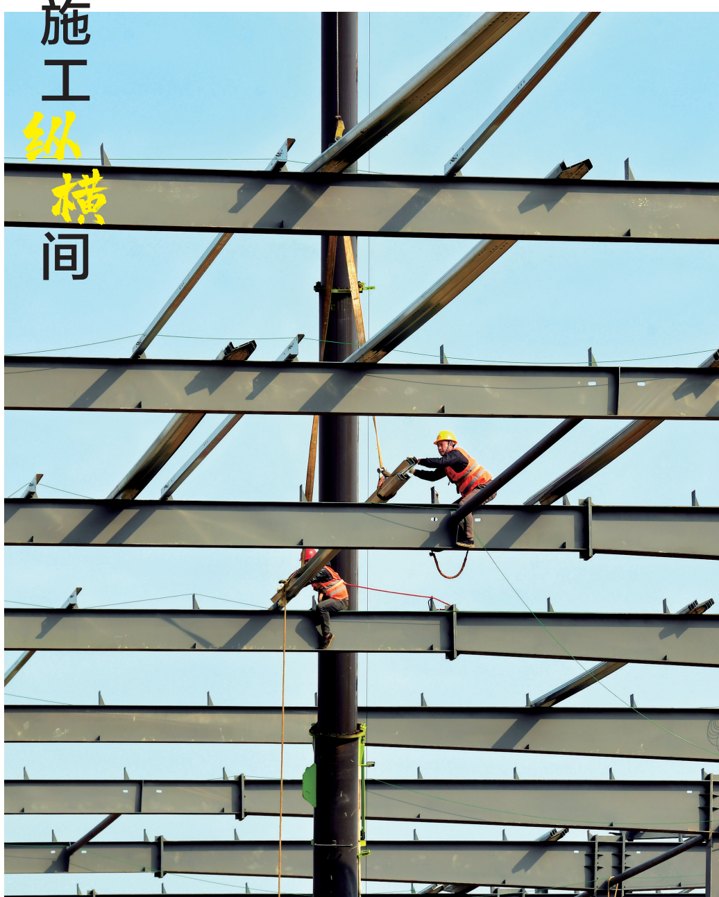
2月15日,咸安经济开发区湖北华劲铝业有限公司,工人们正在搭建钢架厂房。该公司主要为汽车零部件和通讯领域提供高端液态铝合金材料,设计产能20万吨,预计第一批熔炼车间今年5月建成投产。
