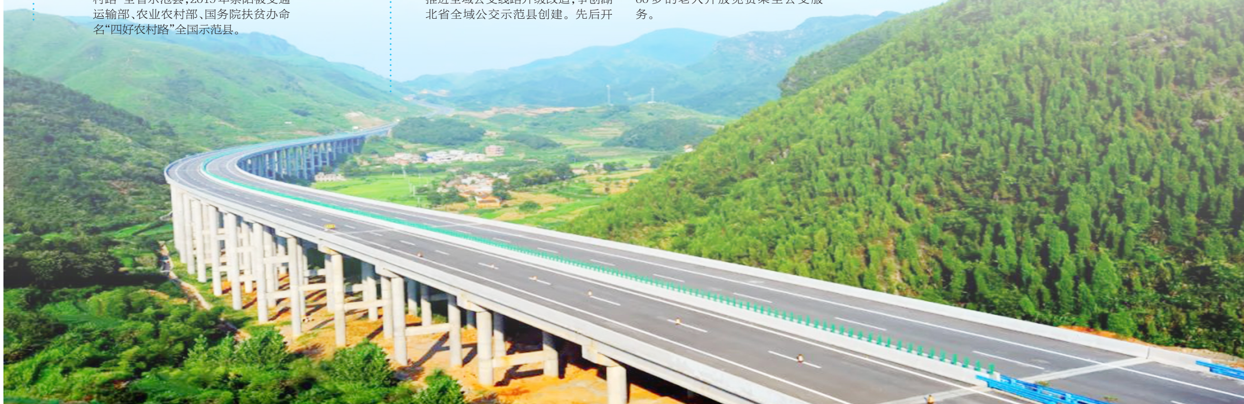
崇阳杭瑞高速公路 张大乐 摄
