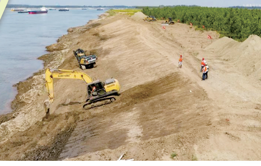
影响处理咸宁嘉鱼段河道整治工程
