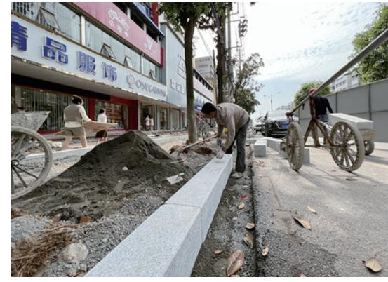
化及商铺前铺装，新建人行道及入户铺装并设置停车位；优化道路开口、转弯半径，改造及新增无障碍缘石坡道，小路口抬高，封闭现状不合理小路口；绿化修复，优化现状绿化景观；整治现状雨污管网，实现雨污分流；对破损路面设施维修，铺装沥青路面；设置机动车和非机动车道，重新交通标线、路灯安装管线工程等。
