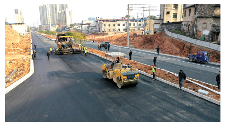
元旦前夕,崇阳县天城镇电力大道东段施工现场,工人正调集机械铺设沥青。该路段是连接城区西片、东片一条重要的通道,全长400多米,设计为沥青砼路面,双向四车道。工程建成通车后,将有效带动当地经济发展,提升崇阳县城市形象和品位。
