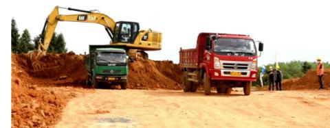
11月20日,107国道赤壁城区外迁段项目建设正酣。据悉,该路段起点位于中伙铺镇南山村沈家,经中伙铺镇、陆水河、茶庵岭镇,终点位于赤壁市茶庵岭镇八庙村。路线全长26.931公里。全线采用设计速度80公里/小时,路基宽度24.5米双向四车道一级公路标准建设。项目建设完成后,将提高该路段的通行能力,改善赤壁区域交通条件,对实现公路交通现代化具有重要意义。 通讯员 聂爱阳 摄
