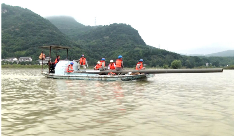
崇阳县电力部门抢修电力设施
