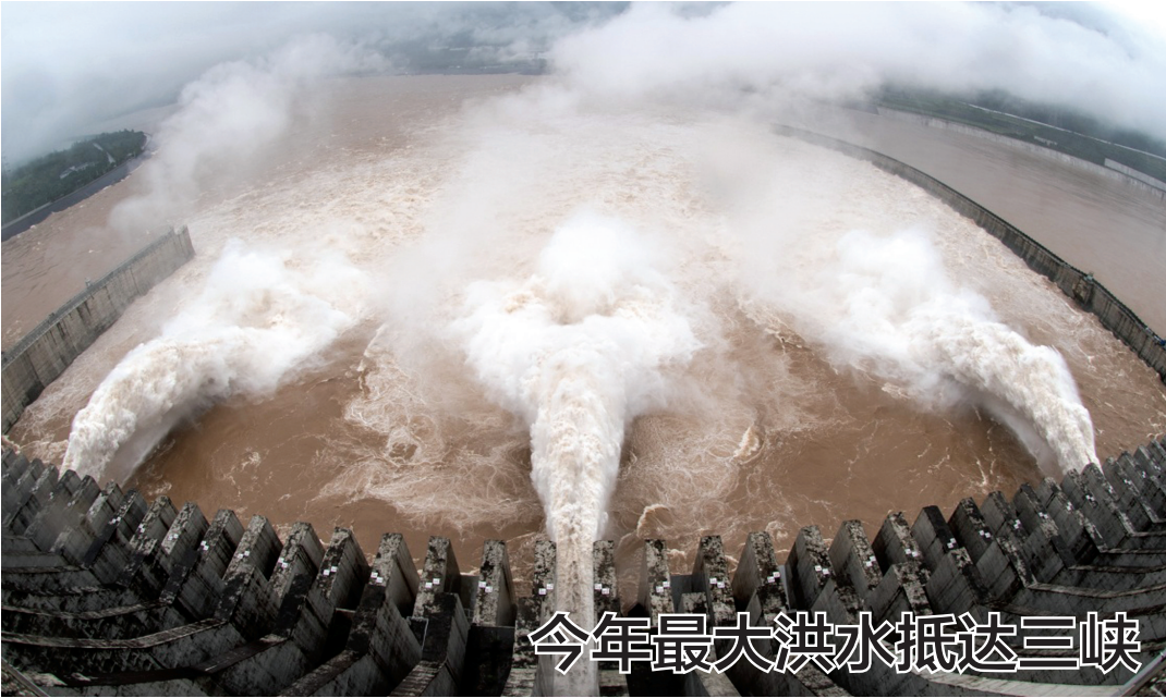
7月18日,三峡枢纽开启泄洪深孔泄洪。受强降雨影响,“长江2020年第2号洪水”于17日在长江上中游形成,三峡水库入库流量快速上涨,18日8时达6.1万立方米/秒。这是今年入汛以来抵达三峡的最大洪水。洪水抵达时,三峡枢纽安全平稳运行。
