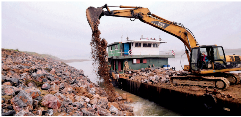
陆水河四清垸堤岸抛石护脚整治现场 黄富清 摄
