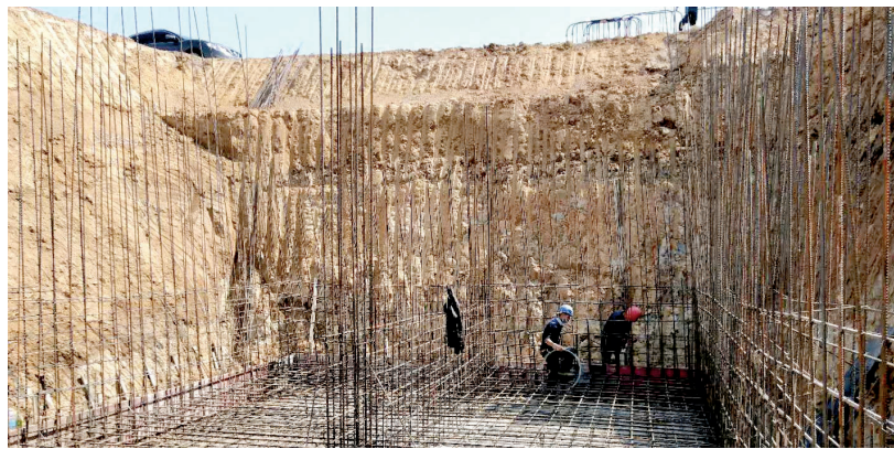
神山镇蔡家湖下垸泵站正在建设中
