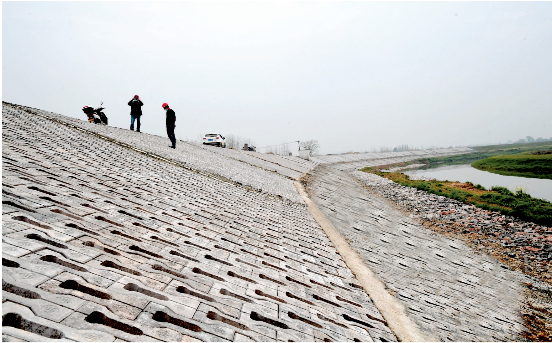
黄盖湖防洪治理工程(湖北部分)大堤堤岸 黄富清 摄
