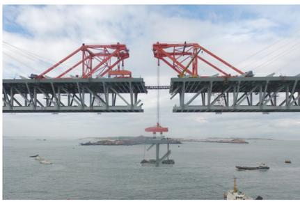
25日,随着一段长17米、重473吨的钢桁梁被精确固定到位,总长16.34公里的平潭海峡公铁大桥合龙贯通。 据新华社
