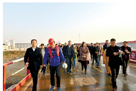
赤壁市政协主席李满林(前排左一)组织政协委员视察赤壁长江大桥建设工地
