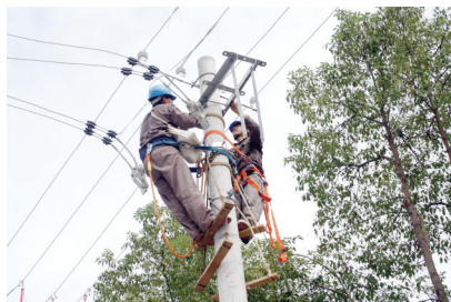
农村电网升级改造架线。
