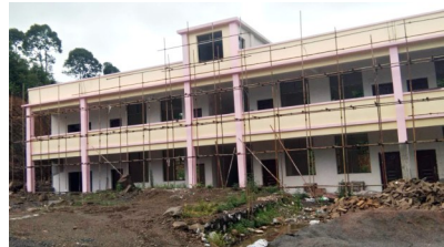
正在建设中的慈口乡大竹小学。
