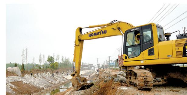
近日,赤壁市赤壁镇东柳村水渠改造施工现场机械轰鸣,施工人员紧张忙碌着。该水渠改造工程投资约388万元,主要建设内容为该村二条渠道清淤、生态护坡。工程全面完工后,不仅将大大提高东柳村渠道输水能力和调节能力,还能有效改善村容村貌,提升人居环境水平。通讯员 王莹 摄
