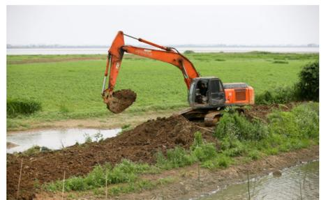
5月7日,在咸安区斧头湖八字口水域处,挖掘机正在挖平斧头湖滩涂与内湖之间的人造坝堤,让坝堤与斧头湖之间变成通水水域。
