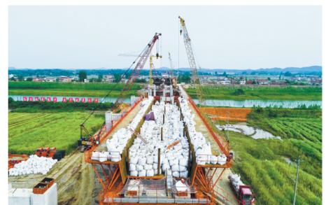
5月5日清晨，经过180多个小时的连续分级架桥施工，赤壁长江公路大桥南岸滩桥箱梁首套移动模架顶压试验圆满成功，达到预压理论值，为现浇箱梁施工提供了安全保障，标志着首孔现浇箱梁施工转入实质性阶段。
