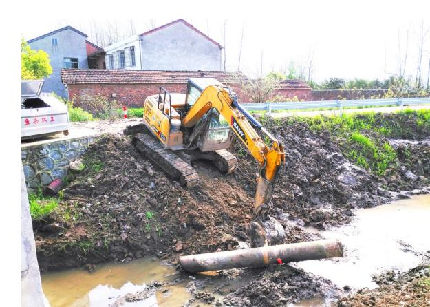
4月1日,鱼岳镇陆码头村一台挖掘机正在进行河道淤泥清理和管道填埋工作。该工程将有效保障沟河畅通,确保灌溉用水,优化河道水环境,为农业高产丰收保驾护航,为乡村旅游建设打下基础。
