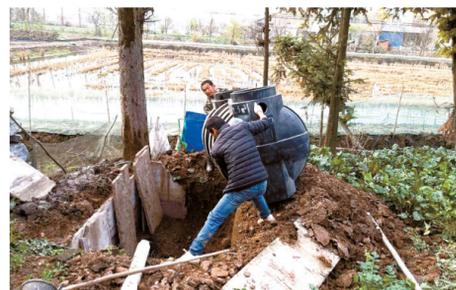
日前,新街镇余码头村村民正在安装全新的三格化粪池。据介绍,使用这套新设备,不需要复杂的拼接程序。设备直接抬放入土坑,再搭建好进水管、出水管,整套安装程序完毕。去年以来,经过各村共同努力,新街镇彻底改变了厕所脏乱差的状况。
