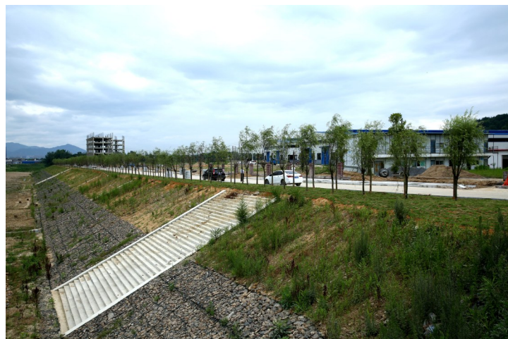
修好隄水河肖岭段河堤
