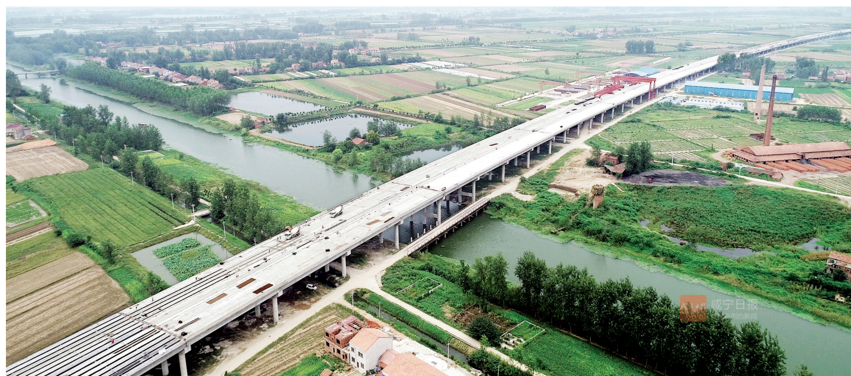
9月26日无人机拍摄的武深高速嘉鱼北段。武深高速嘉鱼北段全长20.6公里,去年7月正式启动建设,一期土建主体工程日前已全面完工,目前正在进行路面铺设、机电交安等后期施工,今年年底将如期建成通车。
