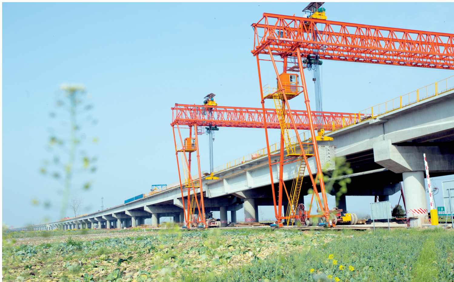
提梁施工剪影
