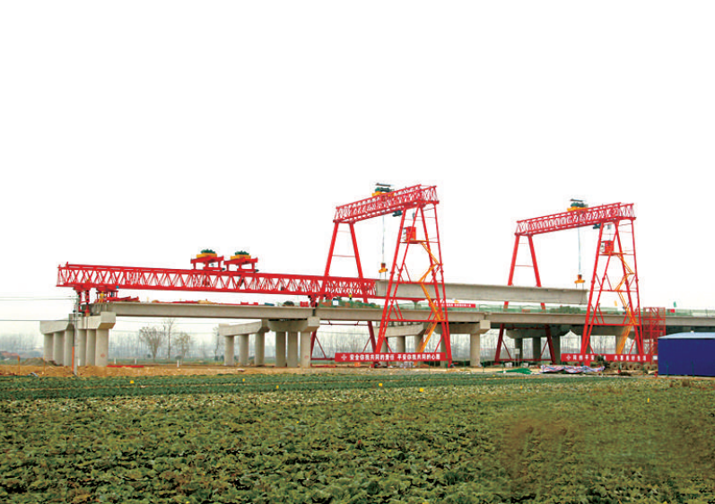
建设中的武深高速通武北段
