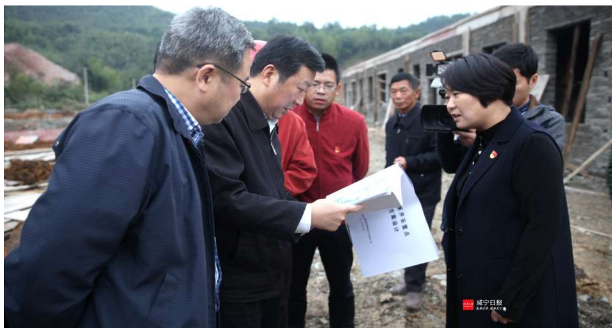
市委副书记、市长王远鹤(左二)在天城镇茅井村易地搬迁安置点建设工地调研
