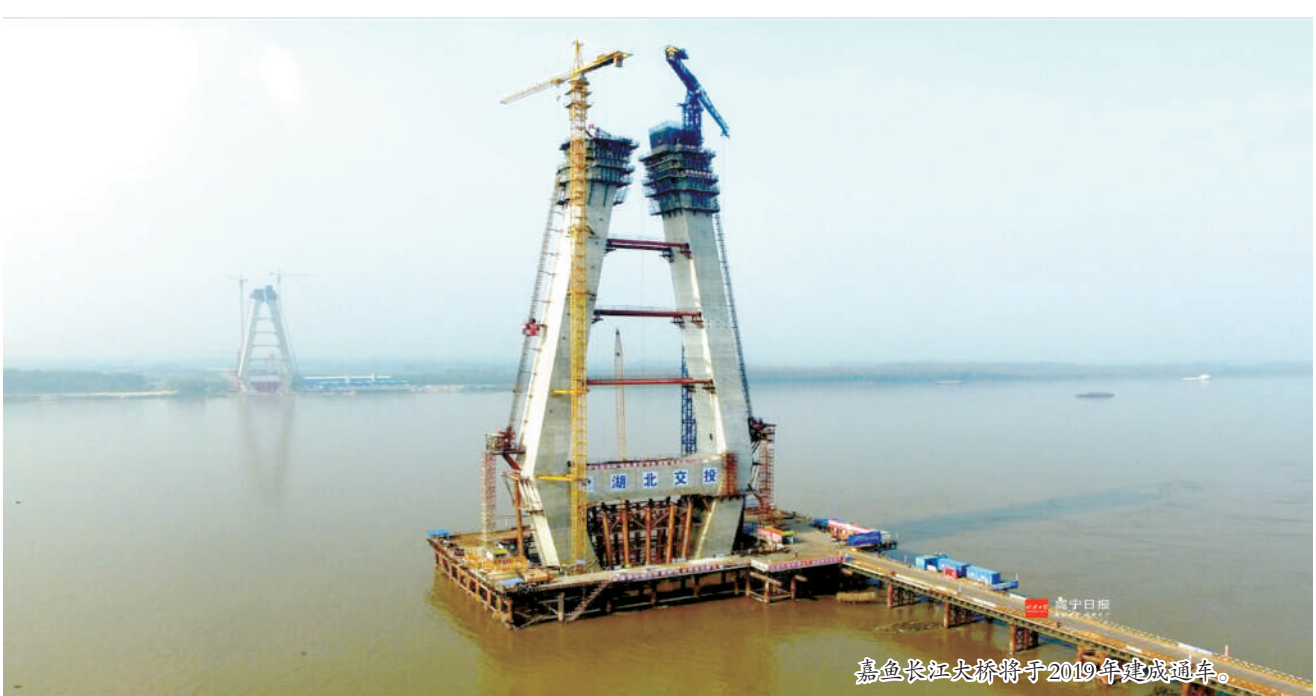
嘉鱼长江大桥桥墩于2016年封顶。
