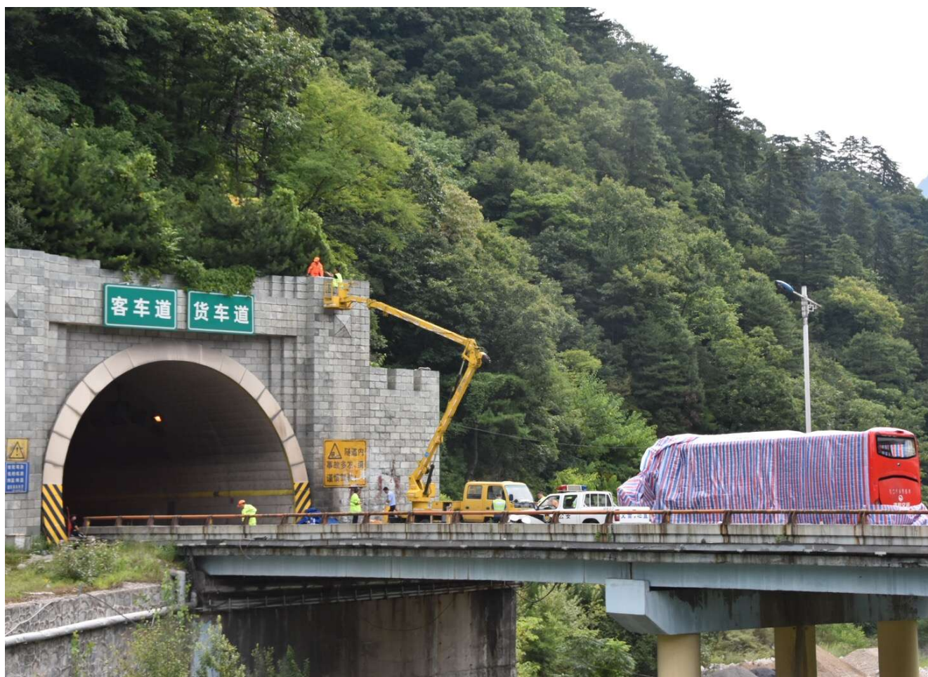
大客车碰撞隧道
