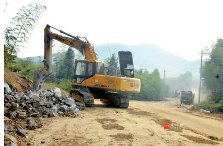
天城镇茅井村通往葛仙山路段建设现场
