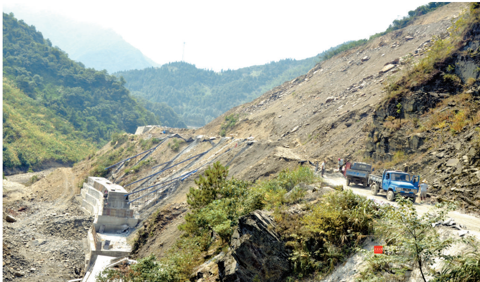
崇阳与江西省接壤的小山界公路建设现场
