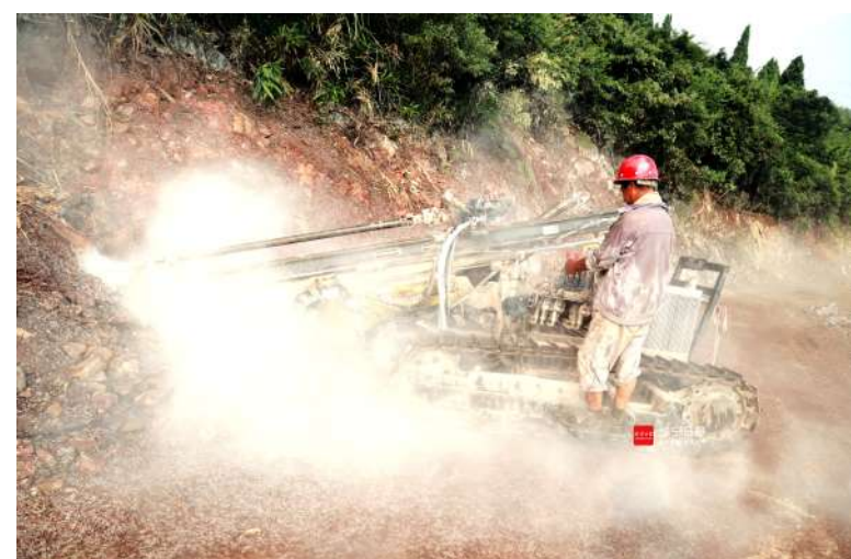
正在打眼爆破作业
