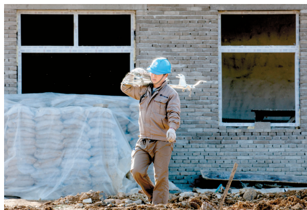
搬运施工金具
