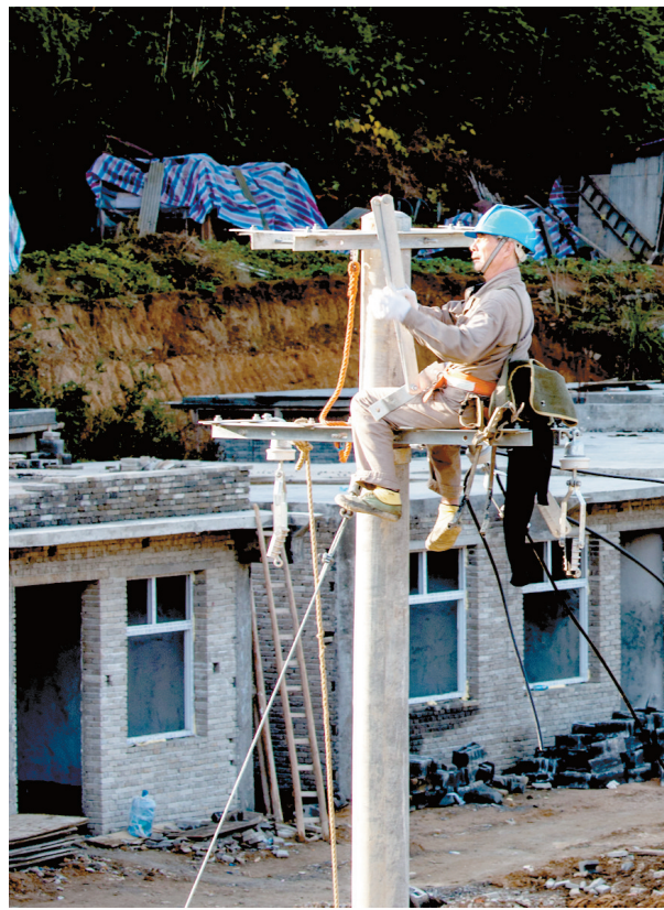
与房屋建设同步架设低压配电线路
