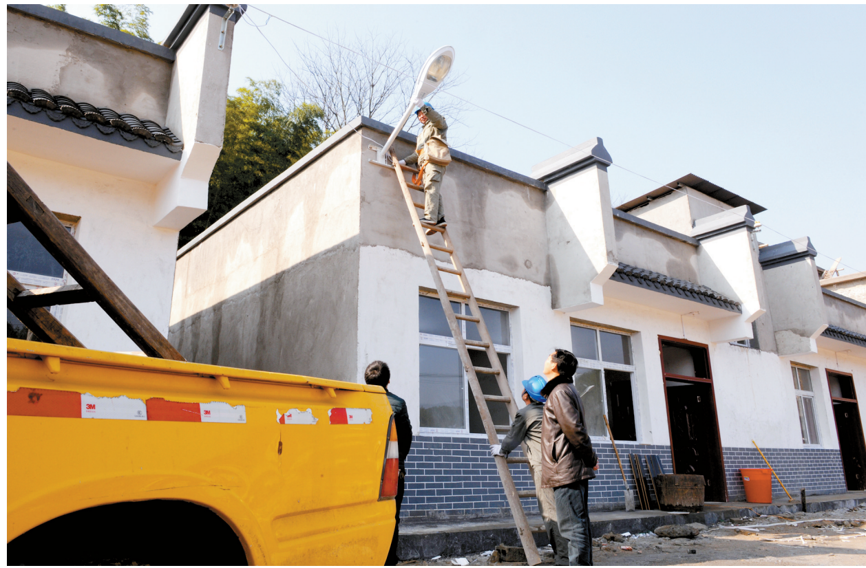
为新落成的异地搬迁房安装路灯
