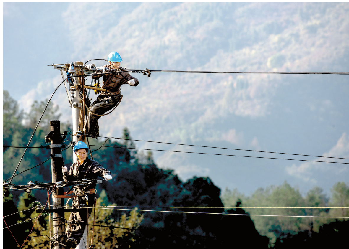
拆旧与新建并延伸配电线路同步进行
