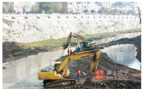
1月16日,在通山县通羊河焦大桥至老财政局河段,挖掘机正在进行清淤作业。
