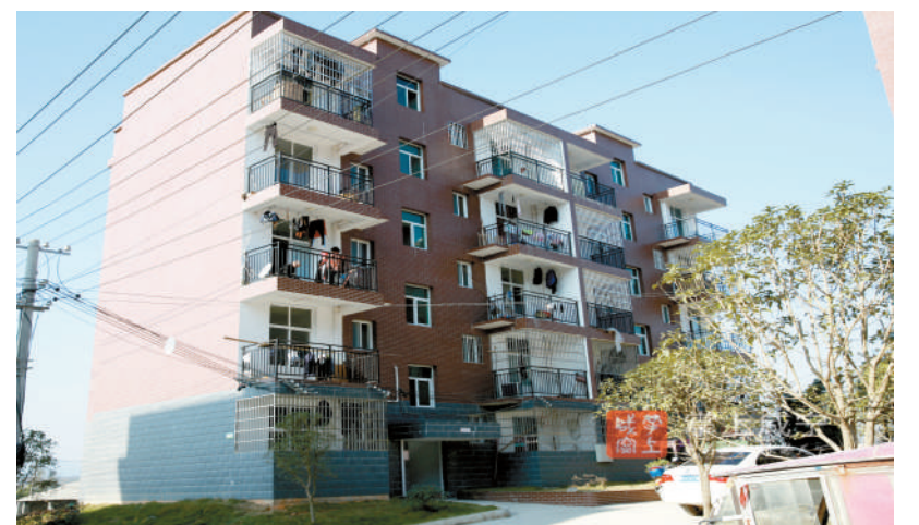
石城镇阳光小区易地搬迁安置点
