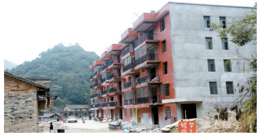
该镇石门双港易地搬迁安置点
