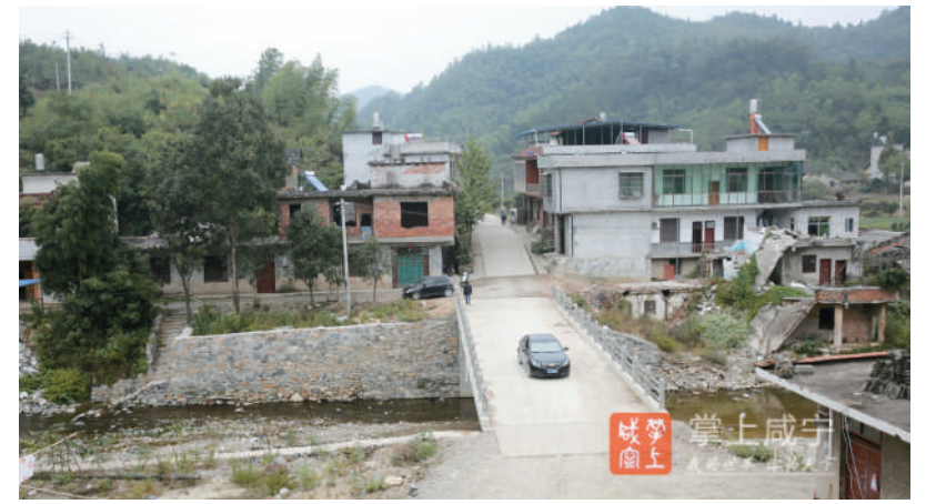
灾后重建的石门大桥
