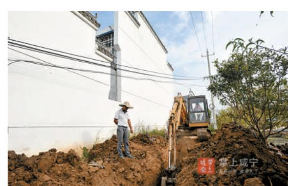
日前,嘉鱼县潘家湾镇四邑新村,工人们正在开挖污水收集沟渠。该村将建设太阳能微动力污水处理工程,采用光电一体化技术,几乎无运行费用。工程投入使用后,该村的生活污水将得到有效治理,新村将更美。
