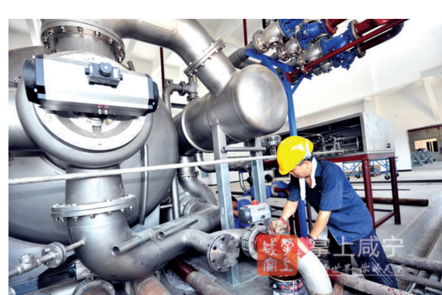
金仕达医疗,目前已经在高新区孵化园租厂房生产,出口创汇能力强,项目总投资3亿元,2016年建成投产后,年产值可达5亿元,税收可达4000万元。金仕达医疗项目设备即将完成安装,预计今年10月全面投产。
