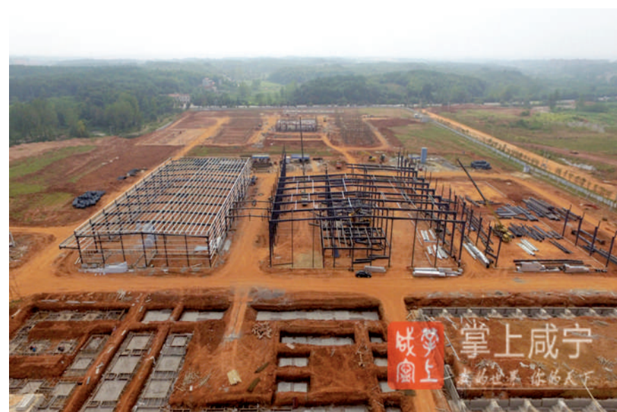
立邦涂料项目前期报批手续全部完成,土地挂牌和建筑设计正在进行,一期房屋拆迁已完成,土地平整、明渠改造和排污管道正在施工,预计年底或明年初投产。一期完成总投资10亿元,2016年底建成投产,形成50亿元产值规模,税收达到5亿元。
