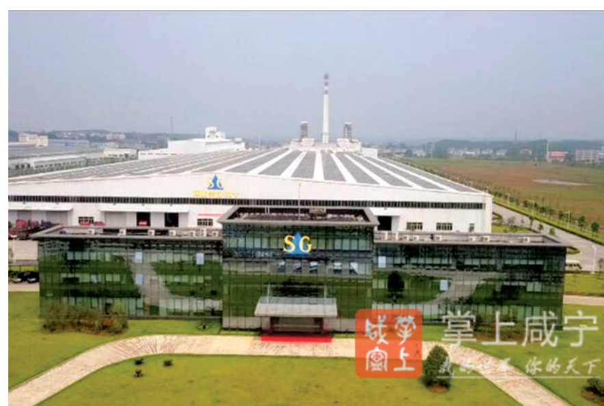
咸宁南玻光电玻璃有限公司系中国南玻集团下属全资子公司,隶属于南玻集团电子玻璃及显示器件事业部。咸宁南玻光电项目计划总投资5.1亿元,建设一条年产400万平方米用于新型超薄LCD显示器的光电玻璃生产线,建设周期自土动工到点火投产,约需12个月,预计每年为国家创造税收6000多万元,提供200个就业岗位。
