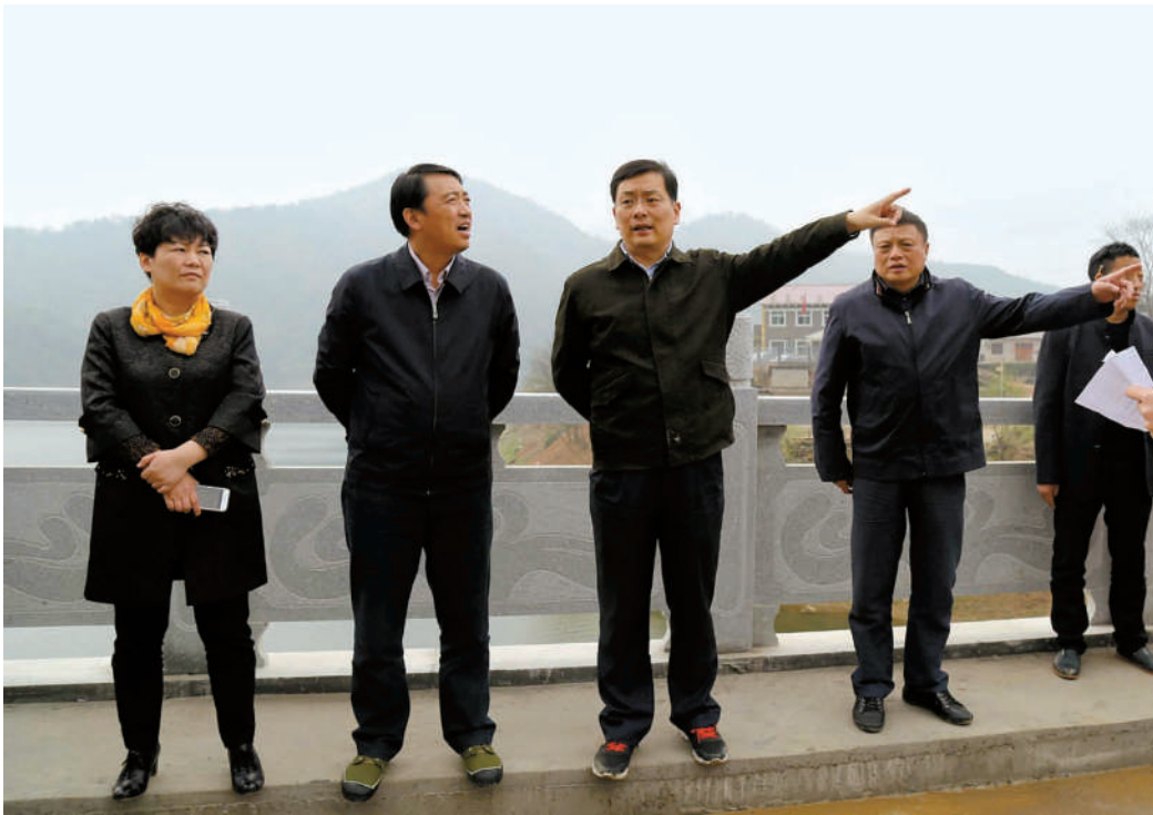
市长小张(左三)一行视察幕阜山生态旅游公路崇阳段建设工程
