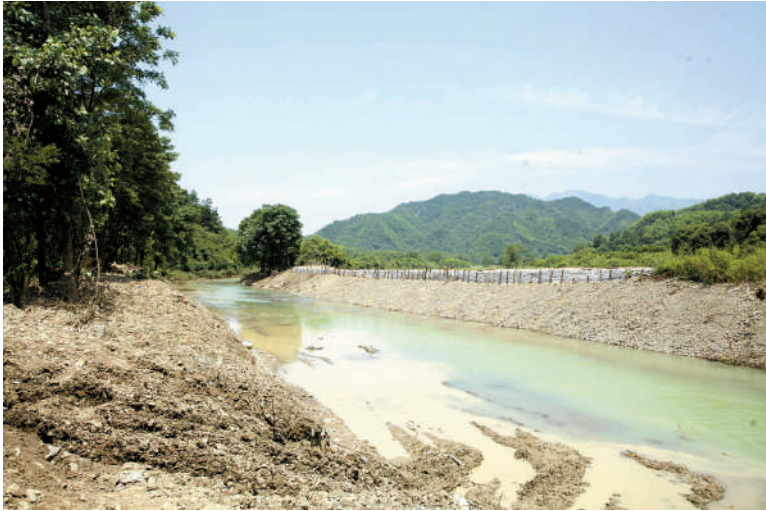
抢修好的被毁河堤
