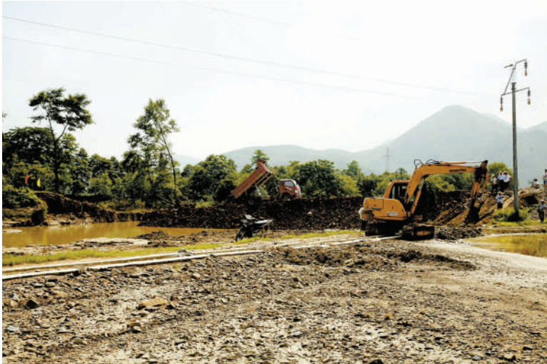
抢修损毁河堤及水利设施
